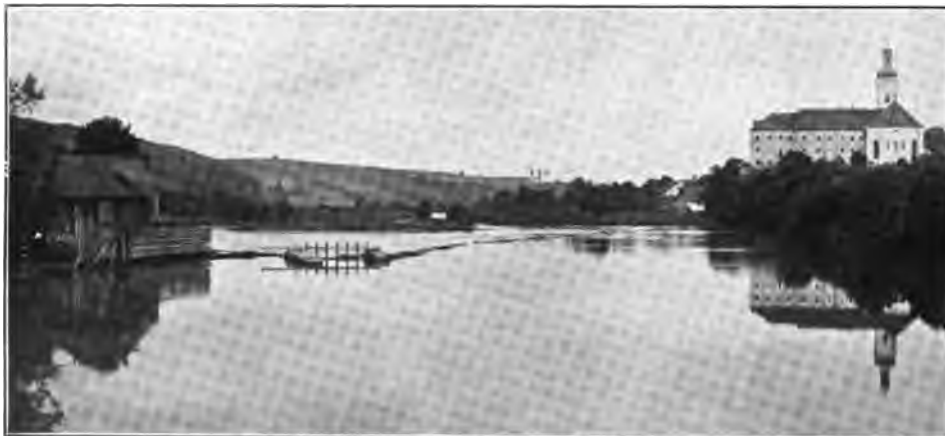
Fig. 162. Walderbach. Ostansicht des ehem. Klosters. (Im Hintergrund Reichenbach.)
